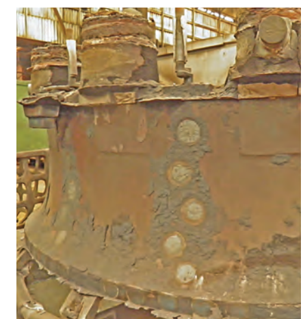
Objekt po odlití a odformování, na němž byly na určitých místech použity tvarovky IZOCAST.
